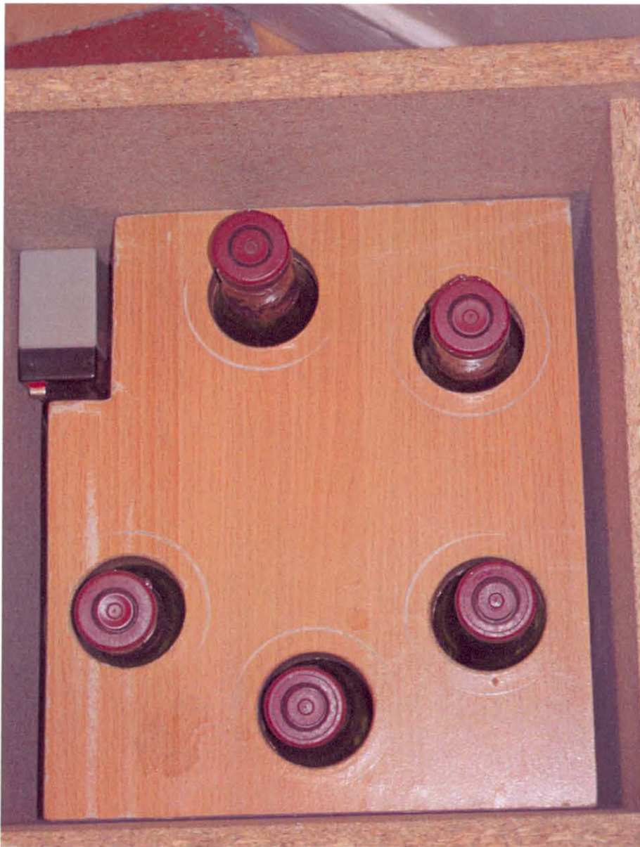
Batterie en position debout, panneau de calage posé sur 5 bouteilles de 1 litre.
